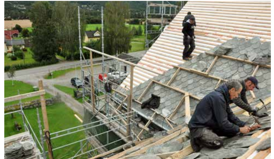
Arbeidet med å rehabilitere tak og vegger på Nes kirke fortsetter for fullt i 2014.
